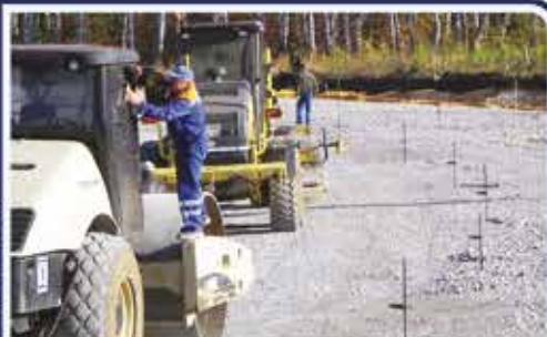
Практическое применение устройства системы нивелирования MOBA GS-506 (2D + ультразвук)
