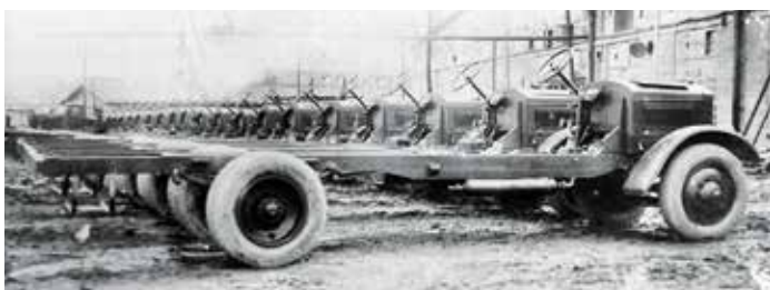
Автобусы Я-6 получили шасси от грузовика Я-5
